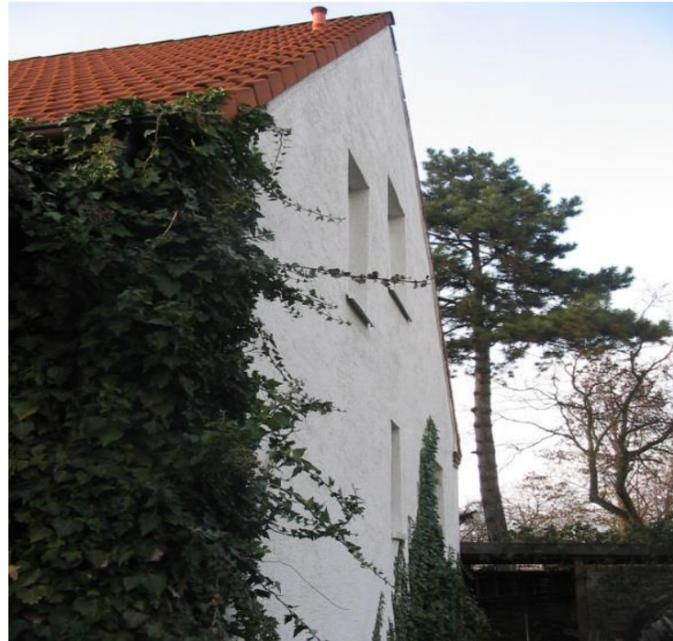
Ein neues Dach, aber keinen Dachüberstand für eine künftige neue Dämmung.
